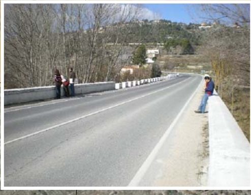
14.- PUENTE DE LA CARRETERA CV-795
